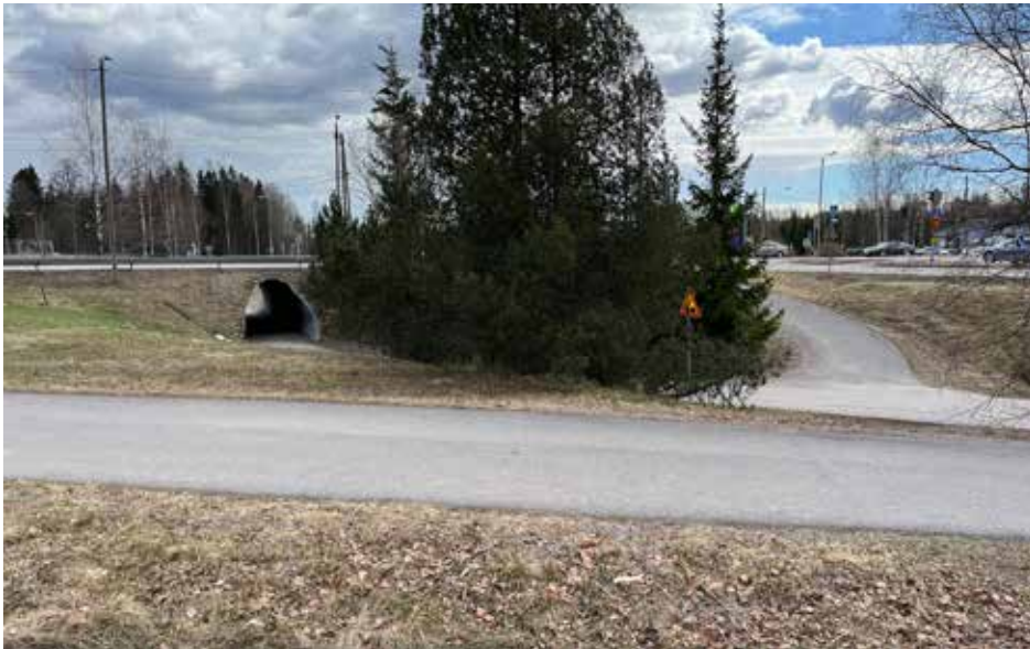
112. Pohjoisempi, Krapin lähellä oleva ”uraputki”-alikulku on avoimempi, mutta etenkin väylien liittymäkohtien väljyyteen pitää kiinnittää huomiota.
