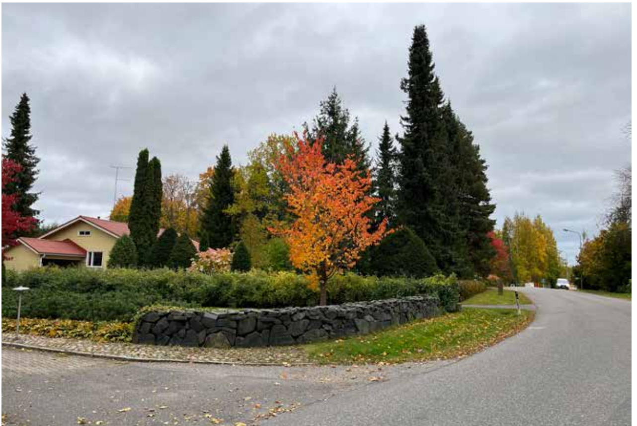
81. Uudehko kylmäkivimuri Kirkkotien pohjoisosan varrella.
